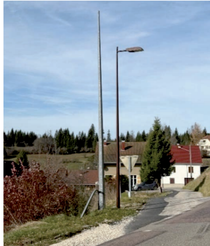
Enfouissement des réseaux et remplacement des lampadaires sodiums par des équipements LEDS
