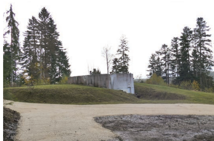
Travaux de défrichage et de nettoyage autour du réservoir.
