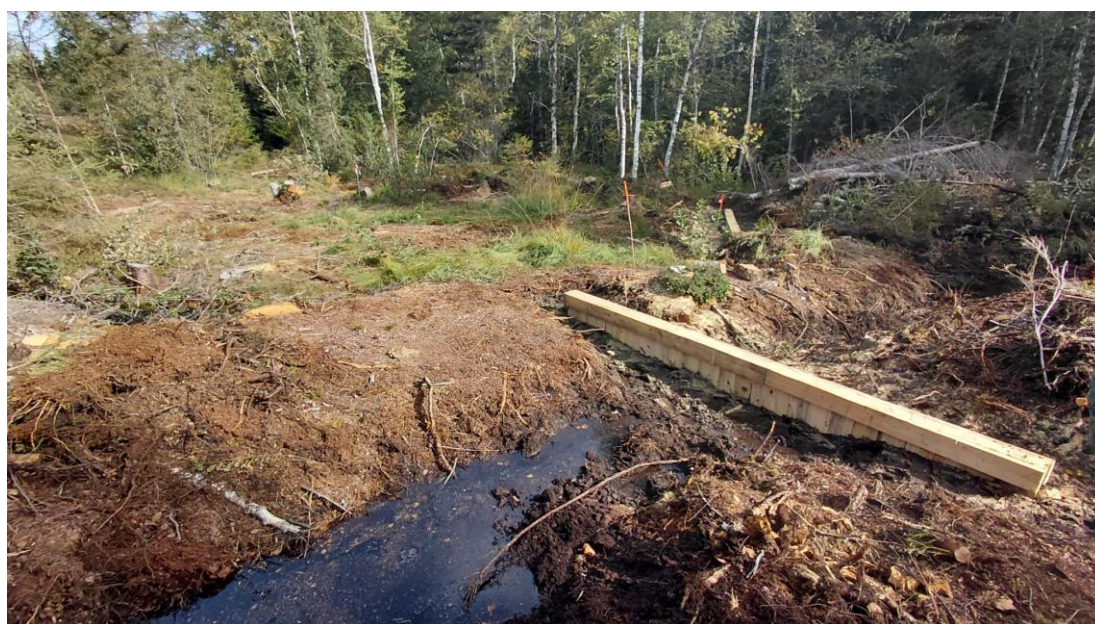
Figure 5 : Chantier de réhabilitation hydrologique, mise en place des palissades pour ralentir l'eau qui s'échappe dans les drains.
