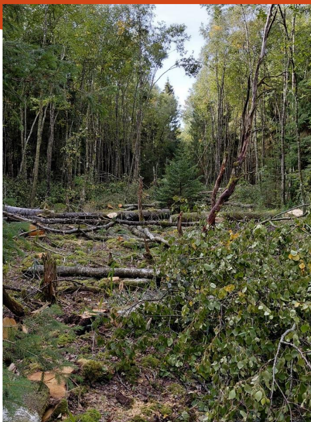
Figure 4 : Chantier de déboisement
